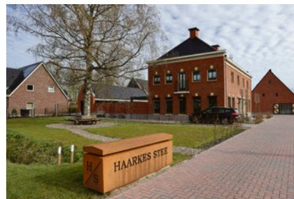
▲ Alle prefab houtskeletwoningen van VDM Woningen worden onder KOMO-certificaat gerealiseerd, waaronder achttien woningen van het nieuwbouwplan Haarkes Stee in Harkstede. Foto: VDM Woningen.
